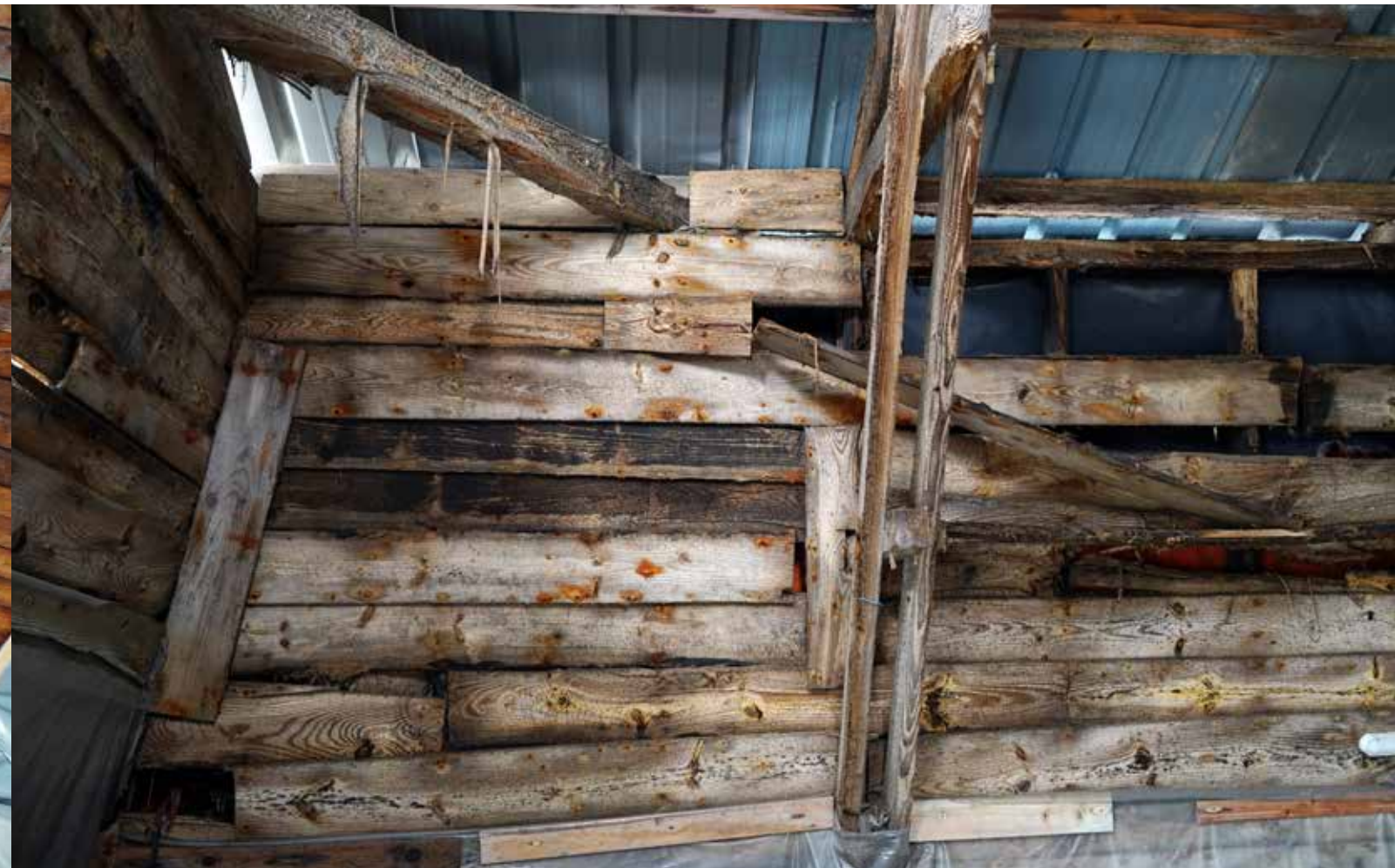
[동주염전 3구 소금창고. 낡고 험 나무 벽에 세월의 흔적이 묻어난다.]
