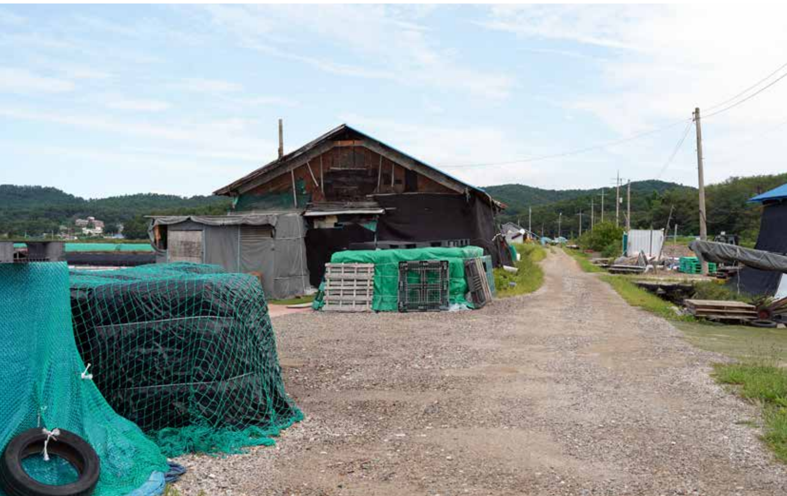
[동주염전 4구 소금창고. 앞에 보이는 포장은 채염 후 간수를 뺀 소금을 20kg 전용 자루에 담아 보관 중인 모습이다.]
